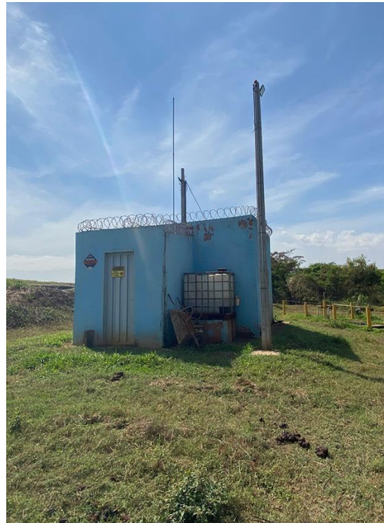
Figura 25 – Casa do Gerador (Sede).
