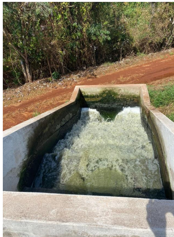
Figura 27 – Escada de Aeração. (Sede)
